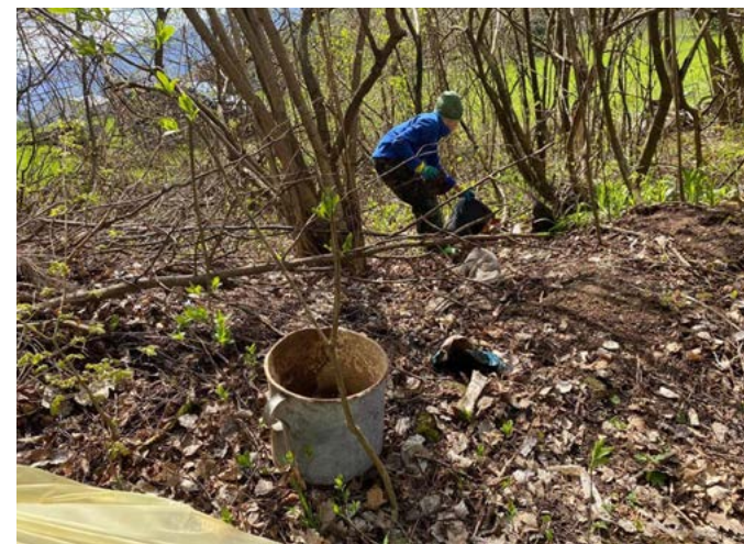
Odstraňovanie protizákonnej skládky
