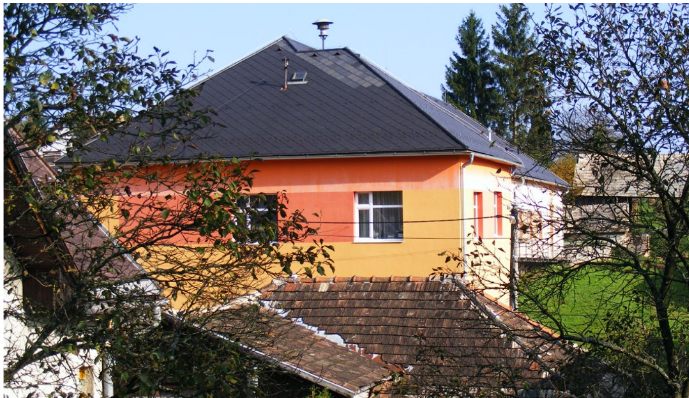
Západojužný pohľad na OcÚ a Dom kultúry
