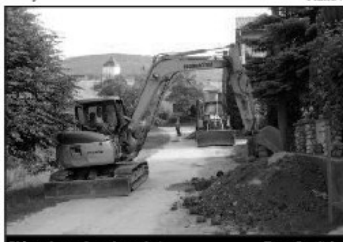
Výstavba vodovodu v obci
