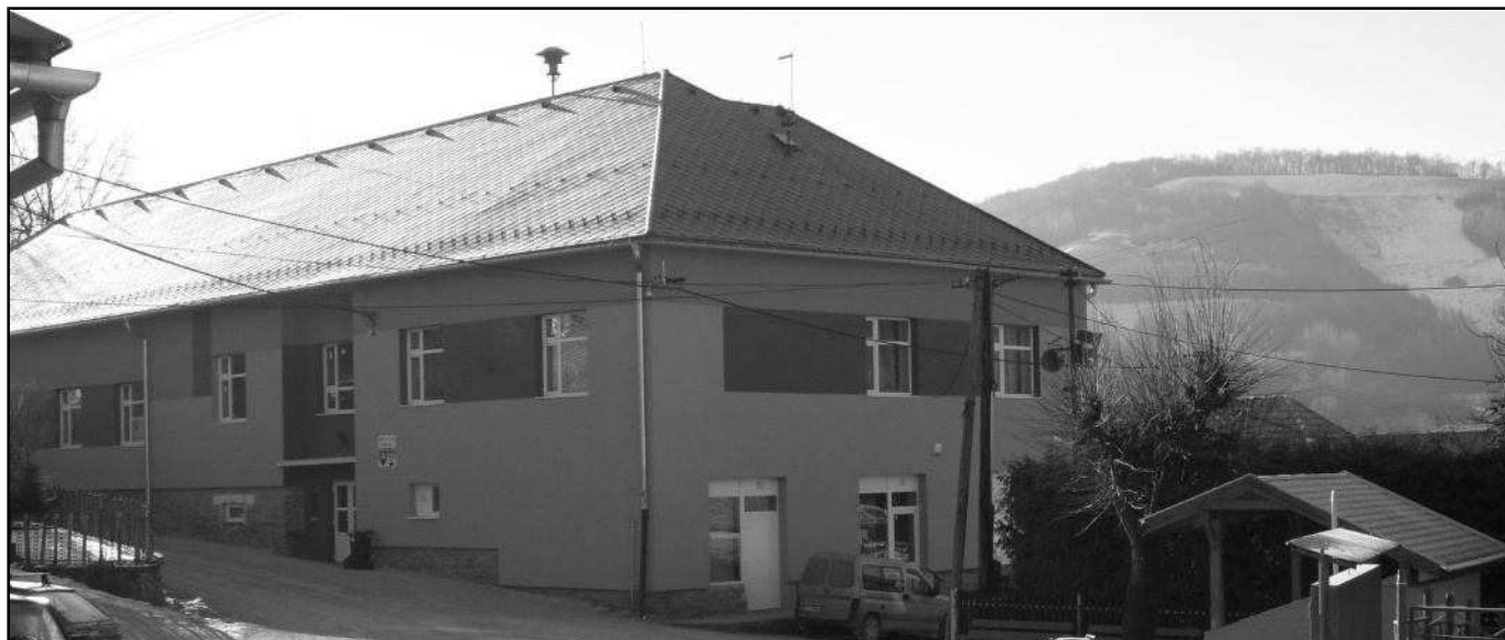
Zrekonštruovaná budova OcÚ a kultúrneho domu
