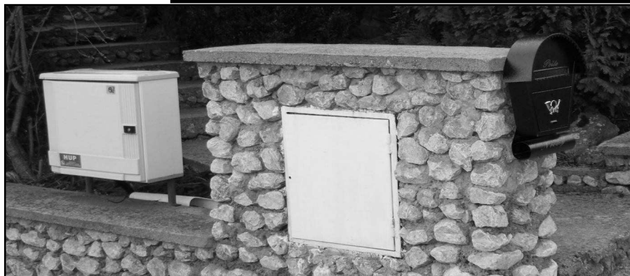
Príklad správneho umiestnenia vonkajších skriniek
